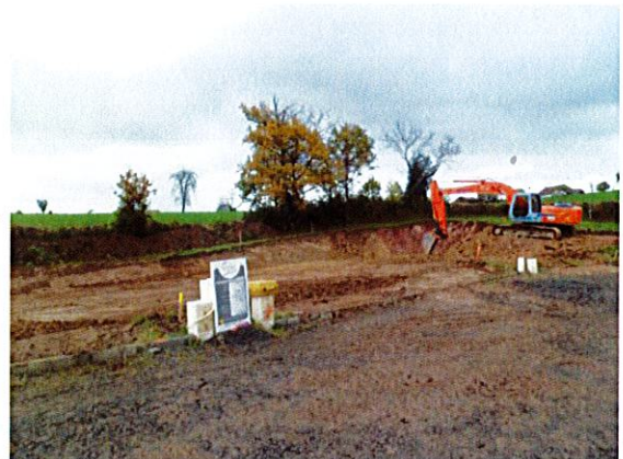
Terrassement aux Places
