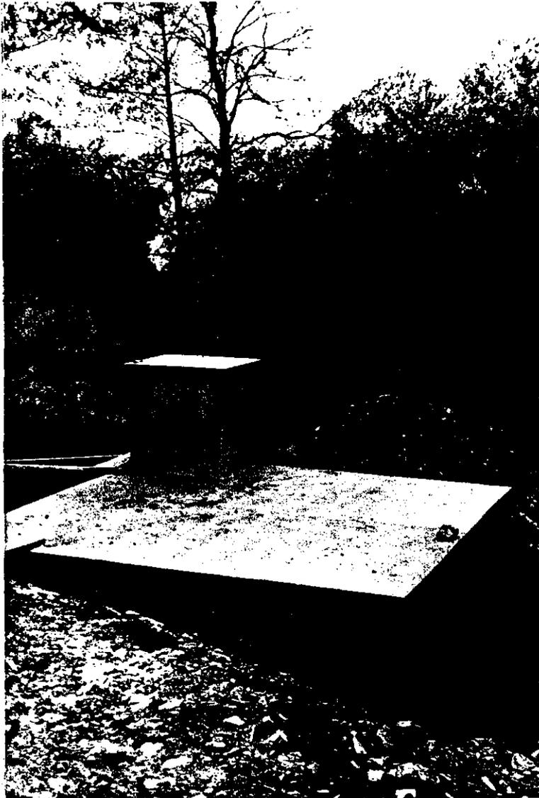
Les travaux de renforcement du réseau sont achevés. La station de pompage de la Plaine du FAU est fonctionnelle depuis juin 1989. Capacité 100 m<sup>3</sup>. Refoulement des pompes: 10 m<sup>3</sup>/H.
