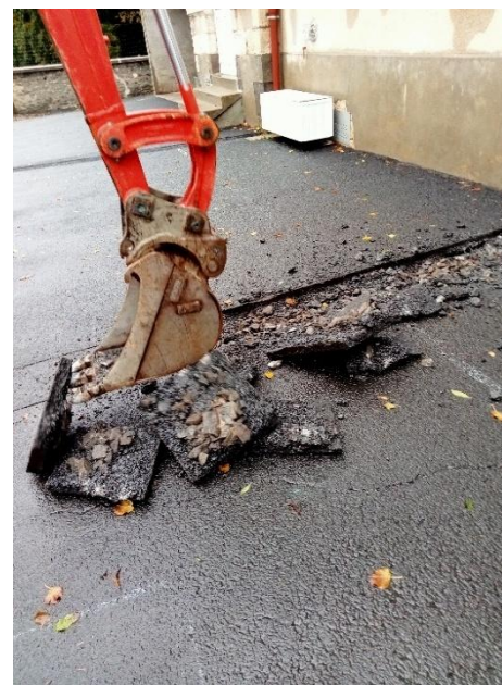
Tranchée pour passage de câbles électriques à la cantine
